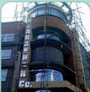
ضدآب سازی نمای ساختمان شرکت آجر نسوز آذرخش زعفرانیه تهران
