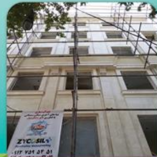
ضدآب سازی نمای سنگی ساختمان کامرانیه تهران
