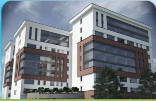
ضدآب سازی نمای سیمانی و آجری ساختمان اداری دانشگاه مالک اشتر تهران
