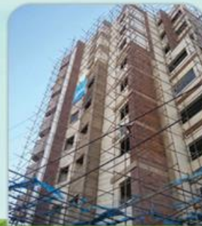
ضدآب سازی نمای ساختمان مسکونی شهرک قدس قم
