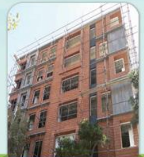
ضدآب سازی نمای ساختمان اداری دیباجی تهران
