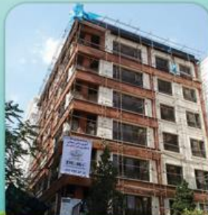
ضدآب سازی نمای ساختمان مسکونی خیابان هویزه تهران
