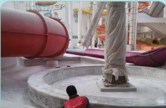
ضدآب سازی سطوح بتنی پارک آبی جیتگر تهران
