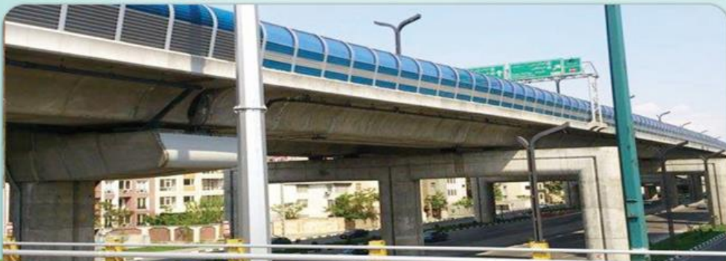
محافظت از نمای زیرین سگمنت های بتنی بزرگراه طبقاتی صدر تهران
